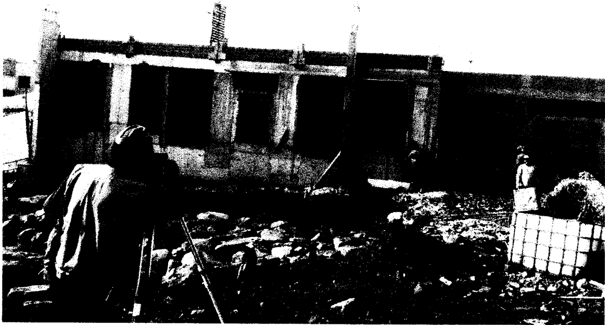
Colocación de niveles en el area de tareas previas
